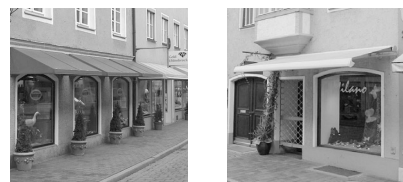
Einfarbige, auf Fassaden abgestimmte Markisen mit geraden Abschlüssen und ohne Seitenschabracken. Ausladung max. 150 cm Durchgangshöhe ca. 220 cm
